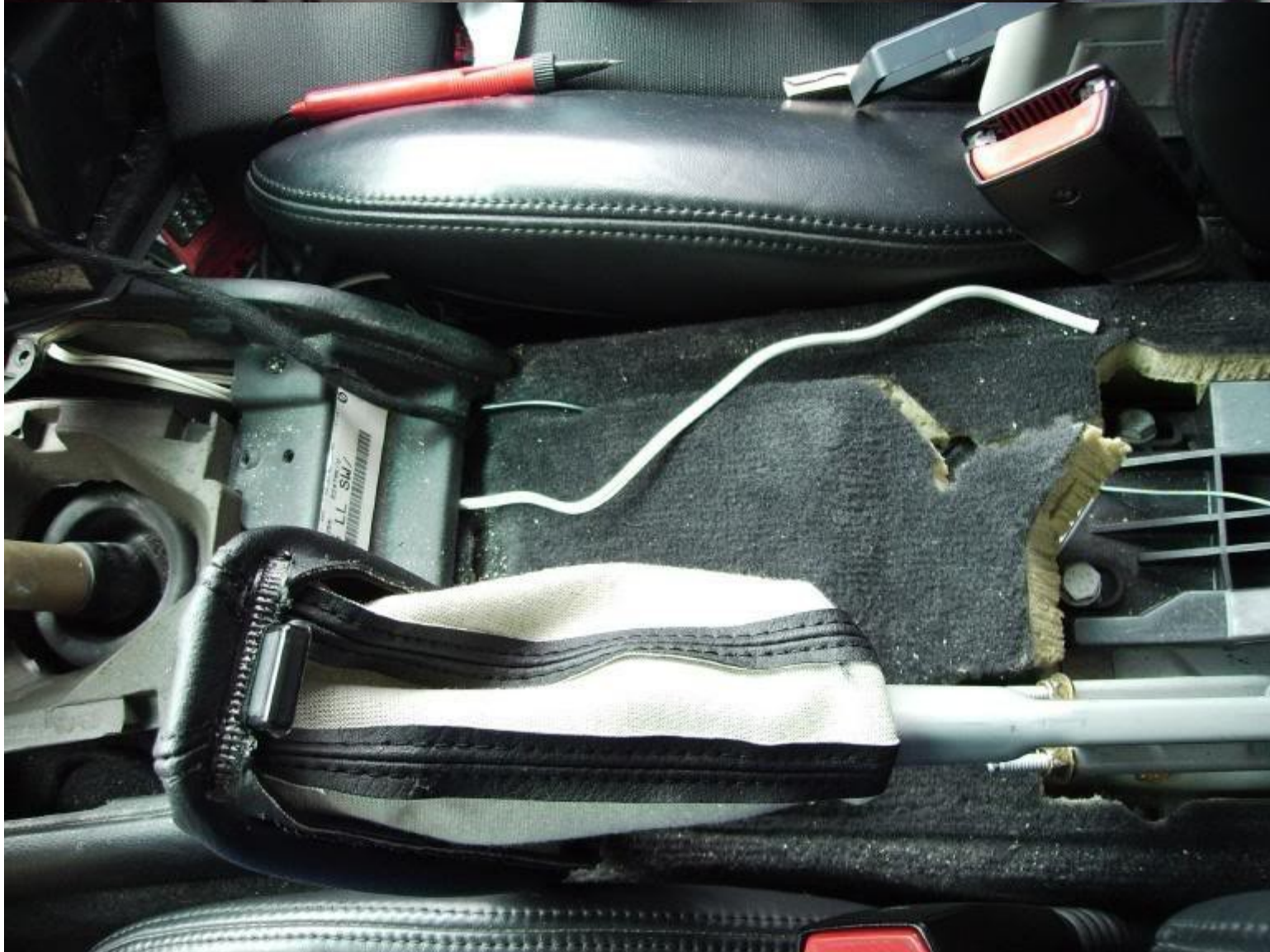
Con una barra pinzamos la tapicería y con la ayuda de una guía pasamos el cable
